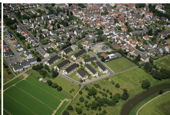
Grundstück nachher mit 57 Reihenhäusern
