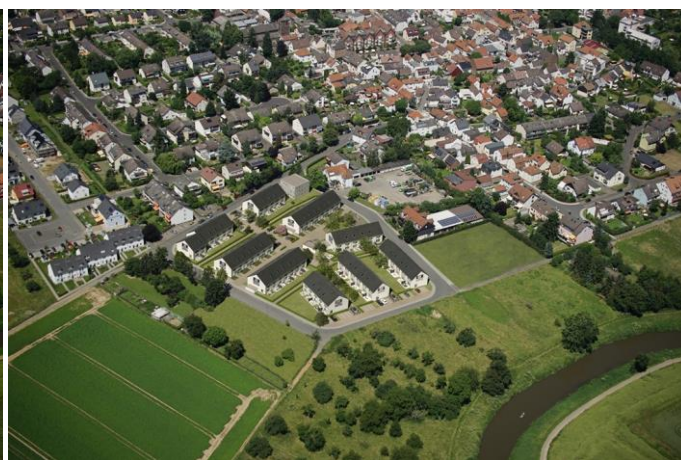
Grundstück nachher mit 57 Reihenhäusern
